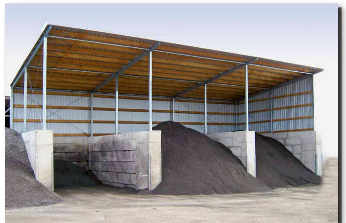
Pulldachhalle PD2 (2-seitig geschlossen) genutzt als Schüttgutlager
