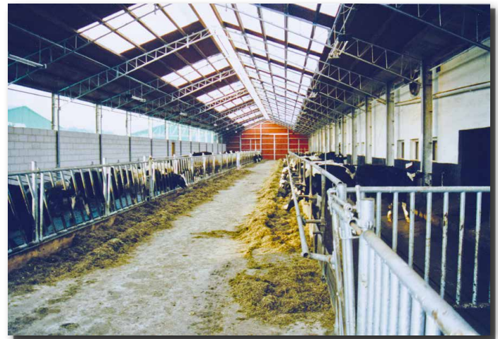
Innenansicht Typ SD13 genutzt als Rinderstall, Seiten teilweise ausgemauert, Lichtbahnen im Dach
