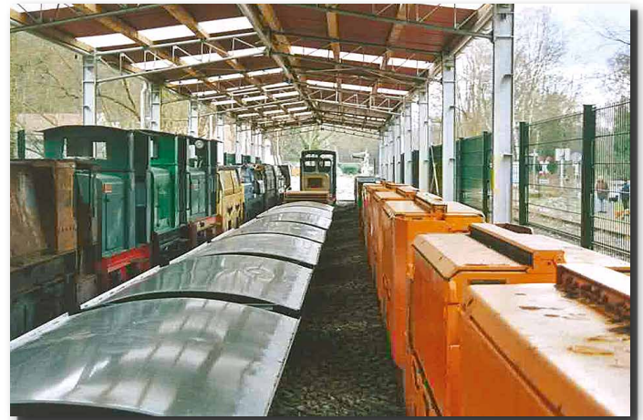
Innenansicht mit je 1 Lichtbahn pro Feld im Dachbe- reich
