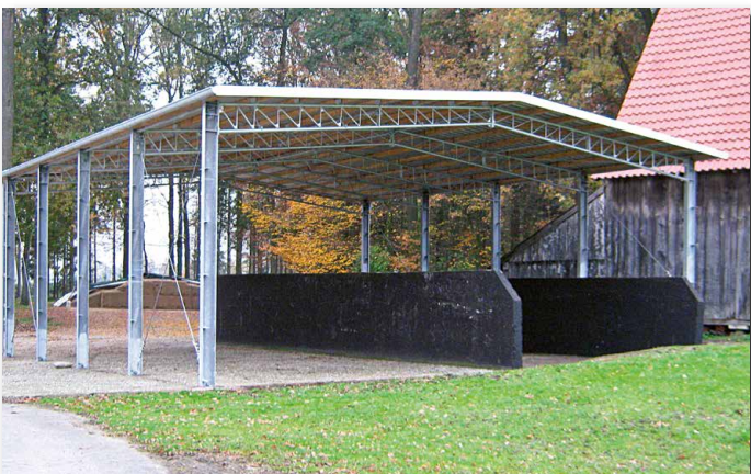
Typ SD12 als Überdachung für ein Fahrсило
