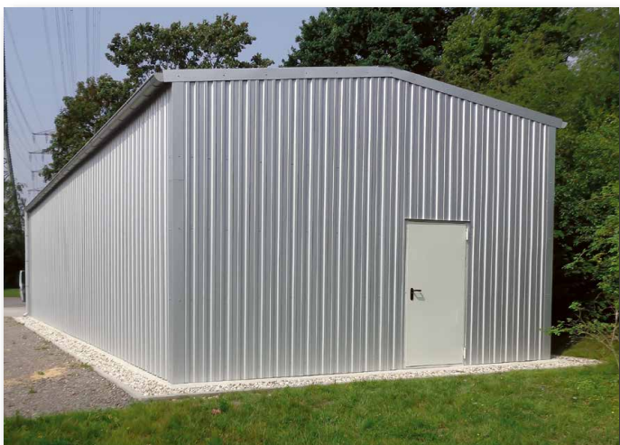
Rückansicht Systemhalle Typ SD 8,00 m mit einer zusätzlichen Mehrzwecktür
