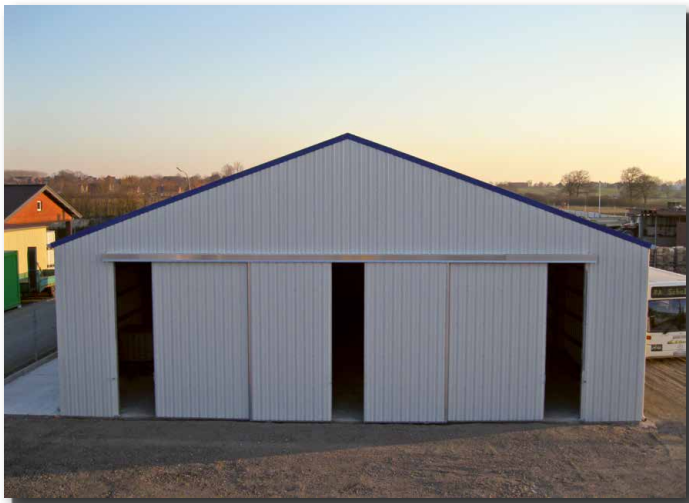
Systemhalle Typ SD15 mit 3 Schiebetoren im Giebel
