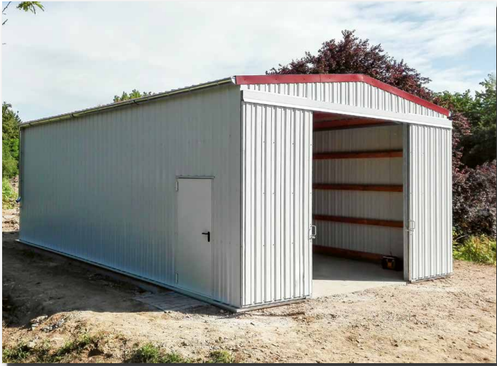
Systemhalle Typ SD 6,00m Breite, Länge 10,00m Schiebetor im Giebel, Mehrzwecktür in der Seite
