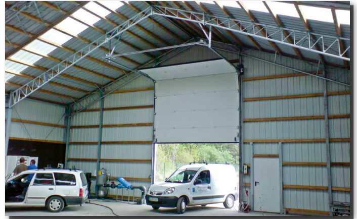
Innenansicht Systemhalle Typ SD15 mit Lichtbahn im Dach
