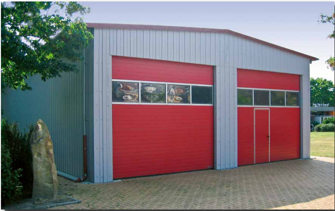
Halle Typ SD12 bauseits mit Sektionaltoren ausgeführt
