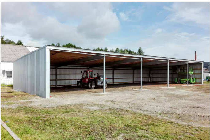
Pulldachhalle PD3 - 30,00m Breite, 12,00m Tiefe (freitragend), Farbe: Aluzink
