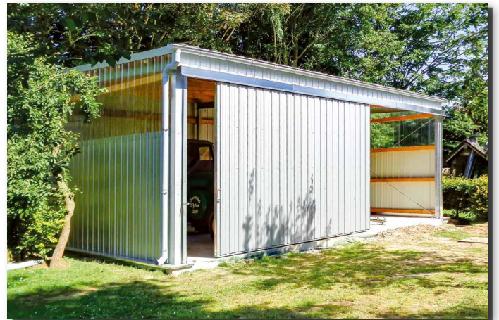
Halle Typ PD4 10,00m Breite, 6,00m Tiefe mit Schiebetoranlage und Lichtbändern
