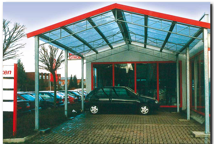
Dacheindeckung mit Polycarbonat-Spundwandplatten 76/18 in glashell
