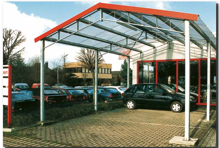
Halle SD 5,00m x 7,00m als Überdachung für Autos
