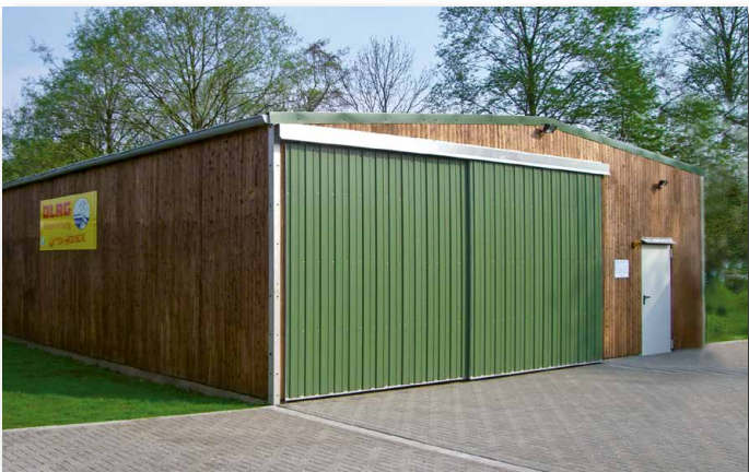
Typ SD 10, 00m x 14,00m für die DLRG Witten-Herbede, bauseits mit Holz verkleidet
