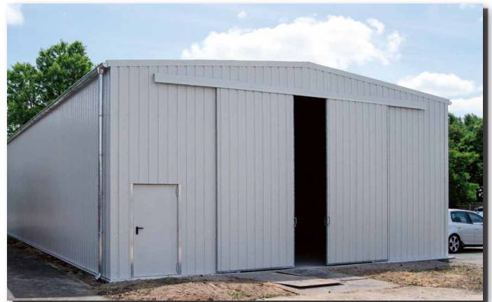
Typ SD 10, 08m Spannweite, 21,00m Länge - eingedeckt mit grauweißem Trapezblech
