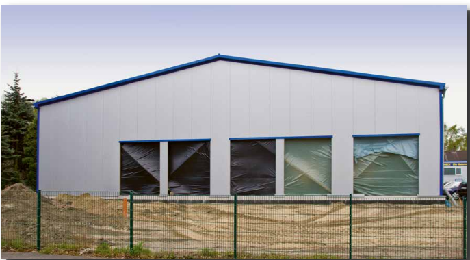
Halle Typ SD 21,00 m, bauseits mit Sandwichelementen isoliert - entstehendes Autohaus
