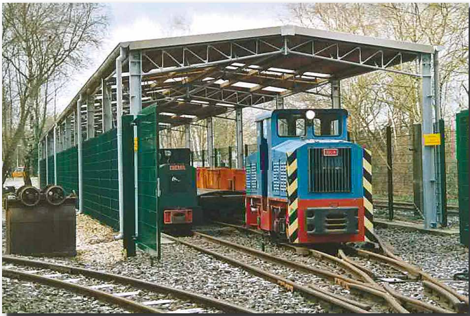
Halle SD 6,00m x 50,00m, Giebelansicht mit Schienen- fahrzeugen
