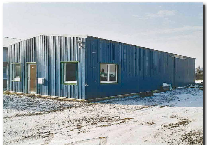
SD 8,00m x 22,50m als Bürogebäude mit angegliederter Werkstatt. Isolation sowie Fenster bauseits
