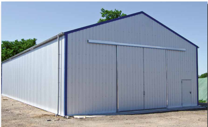
Systemhalle Typ SD11, 07m x 25,00m mit farblich abgesetzten Ortsgängen
