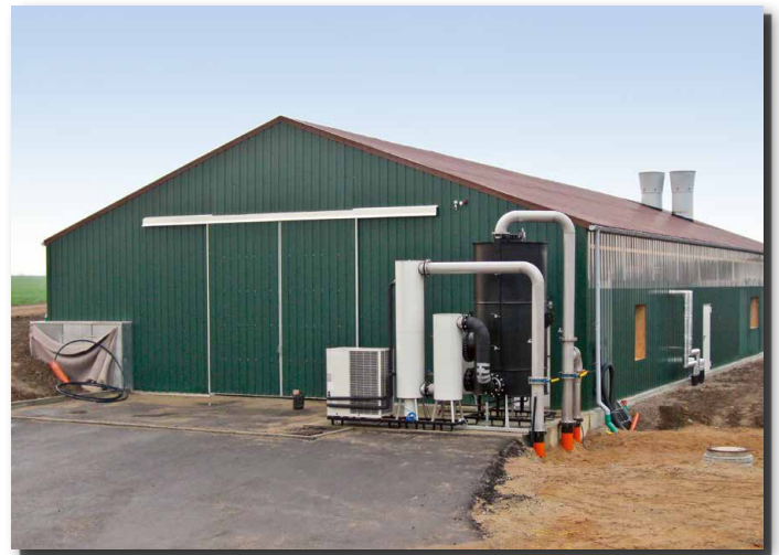
Systemhalle Typ SD15 genutzt als Biogasanlage
