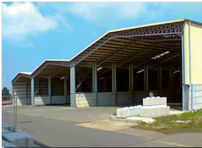
Typ SD 21 erhöhte Version in 3-schiffiger Blockbauweise
