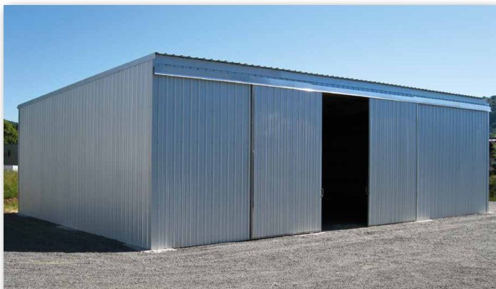
Halle PD4 15,00 m Breite, 8,00 m Tiefe, 4-seitig geschlossen mit Schiebetor
