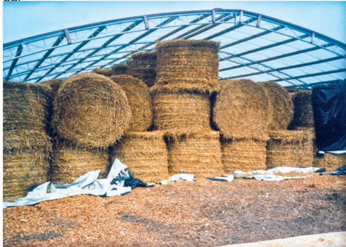
Schutzhalle Typ FW 10,00m als Strohlager
