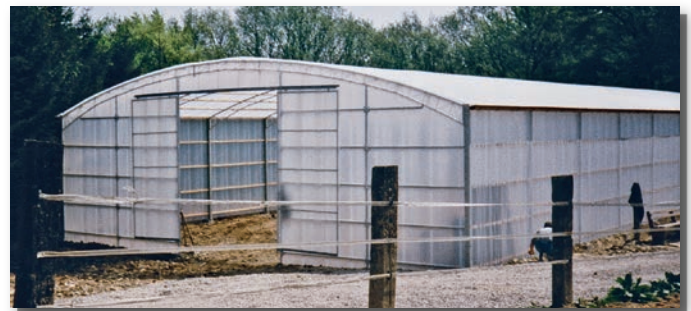
Schutzhalle Typ FW mit milchigen Spundwandplatten
