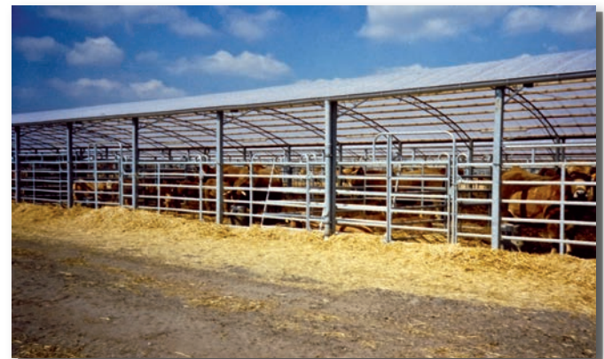
Schutzdächer in Leichtbauweise als Offenstall
