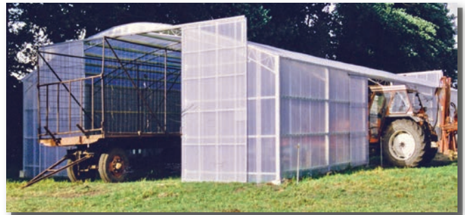
Schutzhalle mit Schiebetorelementen im Giebel und in der Seite
