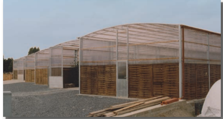
Schutzhalle Typ FW 8,00 m in Blockbauweise
