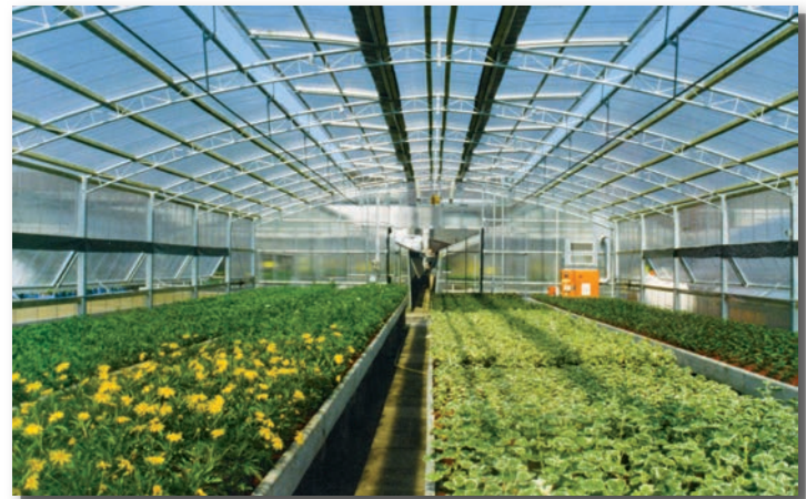
Schutzhalle Typ FW 8,00 m als Gewächshaus mit glashel- len Spundwandplatten eingedeckt
