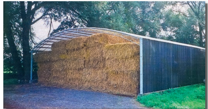
Schutzhalle Typ FW als Strohlager, Holzverkleidung bauseits
