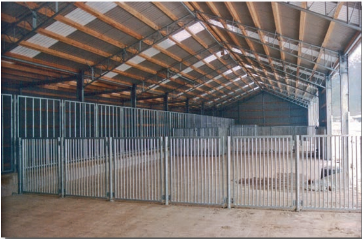
Innenansicht Systemhalle Typ SD 11,01 m als Pferdestallung
