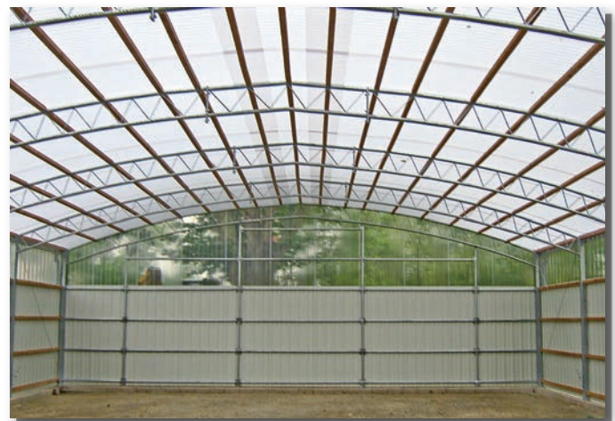
Schutzhalle Typ FW 12,00m - Seiten- und Giebel- verkleidung aus Trapezblech und glashellen Spundwand- platten, Dacheindeckung Spundwandplatten milchig
