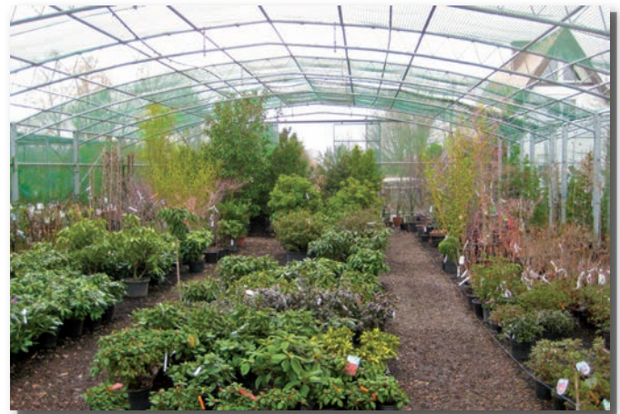
Innenansicht Schutzhalle FW 10,00 m Spannweite, teilweise eingedeckt mit Schattiermaterial
