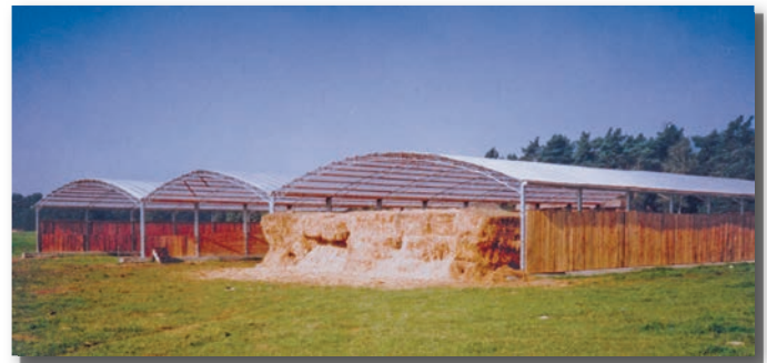
Schutzhalle Typ FW 12,00m in 3-schiffiger Bauweise, Seiten bauseits mit Holz verkleidet
