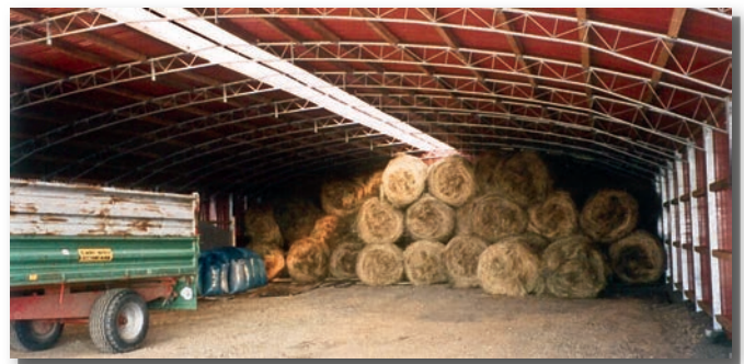
Schutzhalle als Strohlager rundum geschlossen, mit glashellem Lichtband
