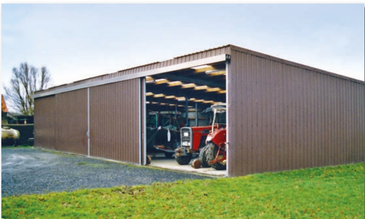
Pultdachhalle PD 20,00 m Breite und 8,00 m Tiefe; genutzt als Maschinenhalle
