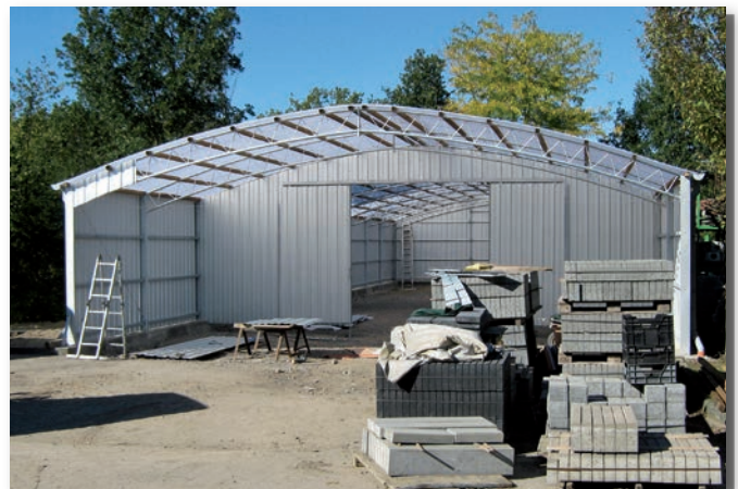
Schutzhalle im Aufbau mit versetztem Giebel: Seiten- und Giebelverkleidung aus Trapezblech. Dacheindeckung: milchige Spundwandplatten
