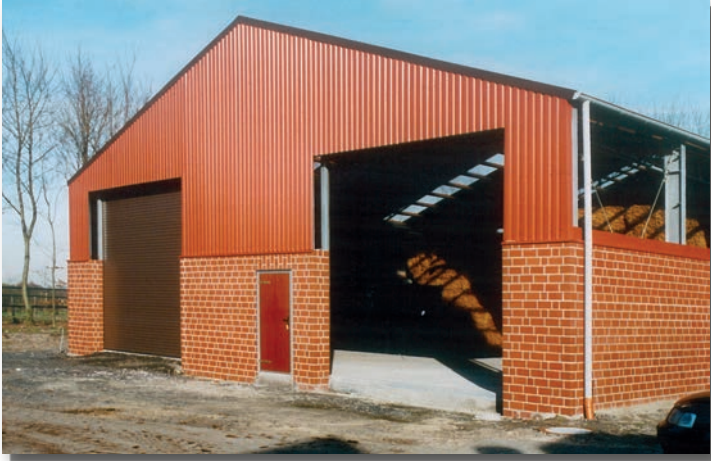
Halle Typ SD 15,10 m, Sektionaltore im Giebel, teilweise ausgemauert
