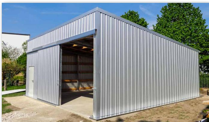
Halle PD4 9,00 m Breite, 8,00 m Tiefe, 4-seitig geschlossen mit Schiebetor - freitragend ausgeführt
