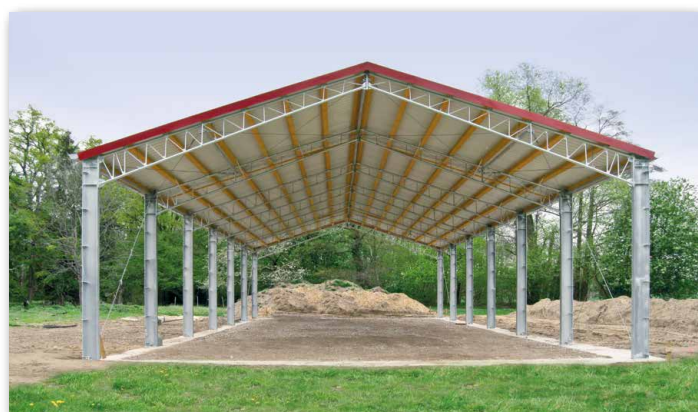
Halle Typ SD 15,04 m x 21,00 m mit braunrotem Trapezblech eingedeckt
