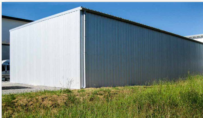
Halle PD4 15,00 m Breite, 8,00 m Tiefe, 4-seitig geschlossen mit Schiebetor - Rückansicht
