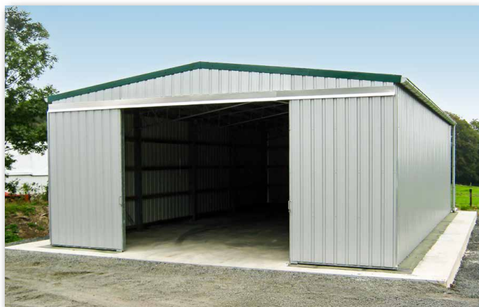
Satteldachhalle Typ SD 8,00 - Länge 13,50 m, mit farblich abgesetzten Orgängen
